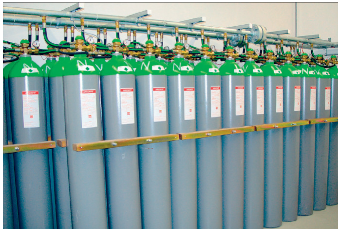
Abbildung 8: Löschgasbatterie Stickstoff
