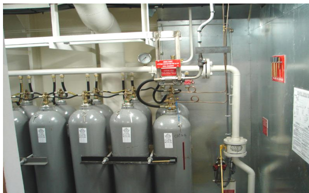
Abbildung 7: CO 2 Gasdruckanlage
